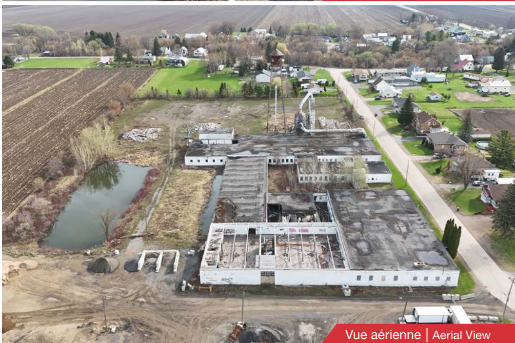
Vue aérienne | Aerial View
