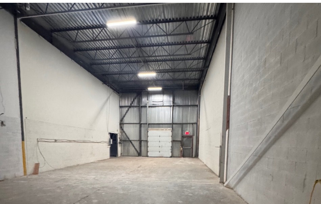
Unité | Unit 1324 Quai de chargement | Truck-level Door
