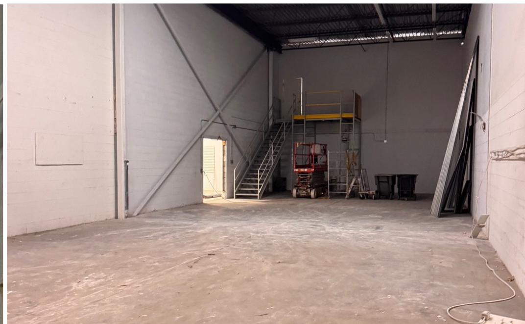
Unité | Unit 1324 Entrepôt | Warehouse
