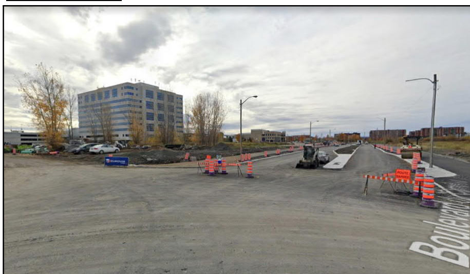
01 - Intersection Boulevard du Carrefour et Centre de préservation (2020)
