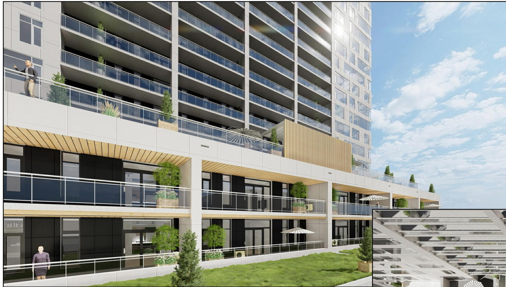
Vue Logements des 3e et 4e étages
