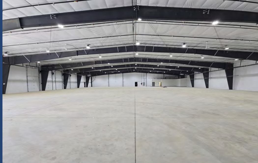
4 Dock Doors / 1 Roll Up Door
