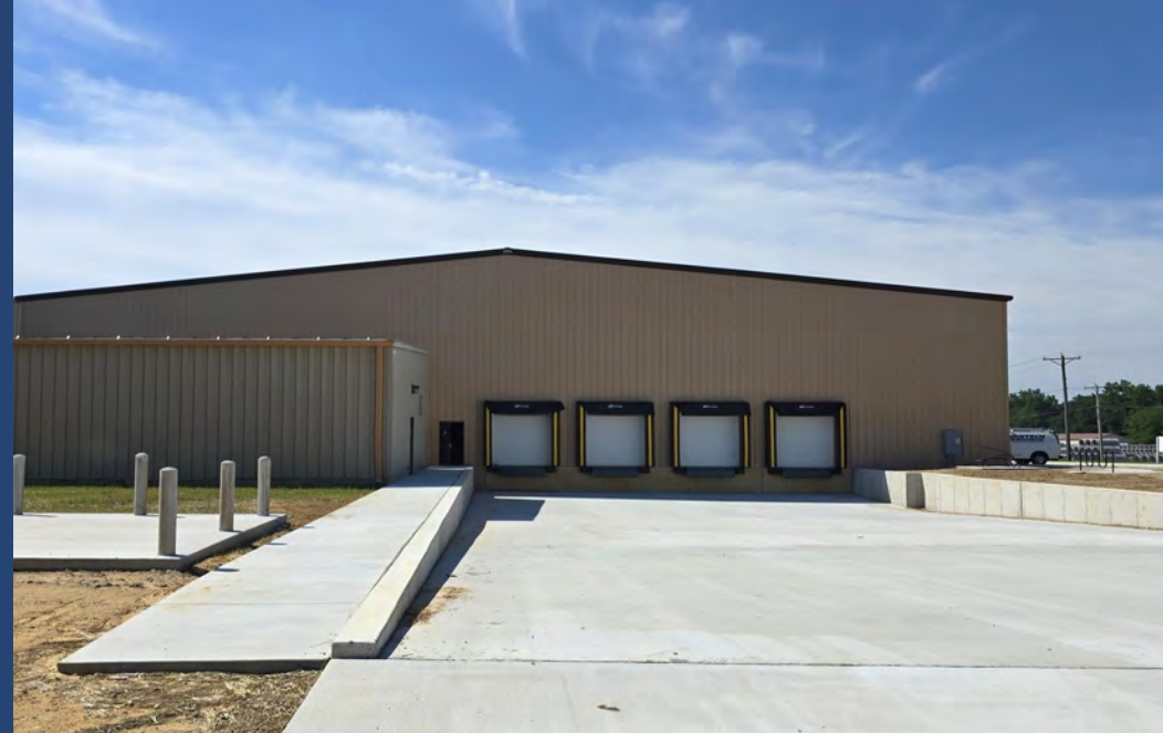
4 Dock Doors / 1 Roll Up Door
